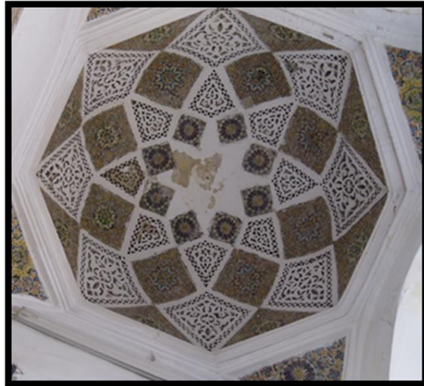
الصورة 17: قبة بقصر عزيزة تزينها زخارف جصية بأسلوب التوريق و تكسوها بلاطات خزفية
