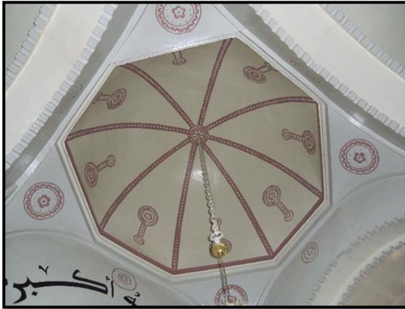
الصورة 14: زخرفة نباتية مرسومة على الجص تزين باطن قبة جامع سيدي لخضر بقسنطينة قوامها
